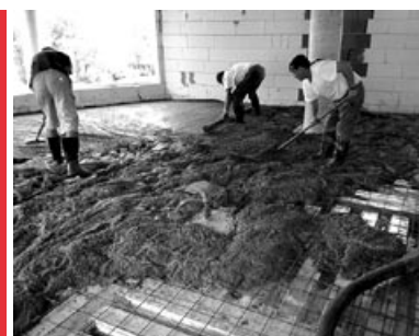
Pokládka tradičního cementového potěru
