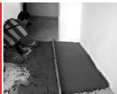
Hlazení tradičního cementového potěru
