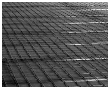
Tradiční cementový potěr - vyžaduje vyztužení
